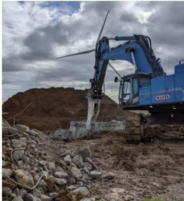
Figure 28 : Retrait de la virole, parc éolien de Bougainville (80), Boralex septembre 2022
