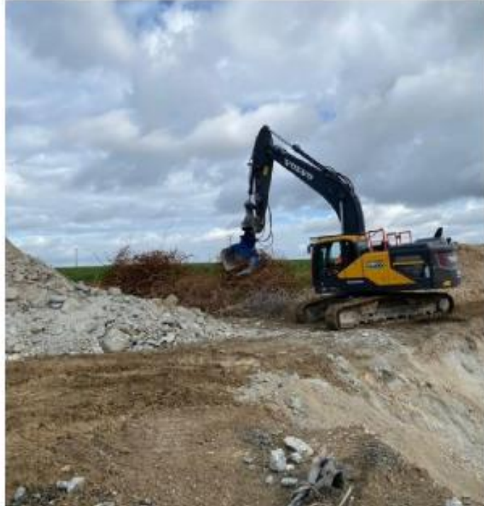
Figure 30 : Séparation du béton et des fers de fondations, parc éolien de Bougainville (80), Boralex septembre 2022
