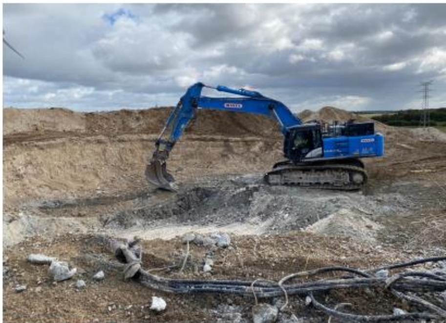
Figure 29 : Excavation totale de la fondation, parc éolien de Bougainville (80), Boralex septembre 2022
