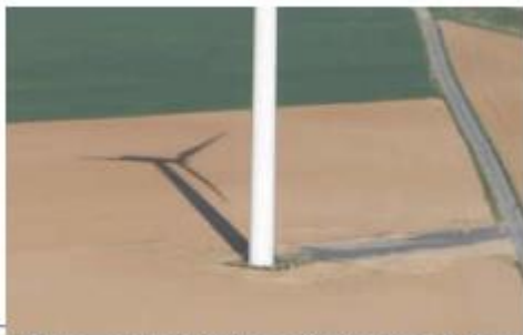
Photographie 3 : Ombre projetée d'une éolienne (source : parc éolien de Vauvillers, Somme)
