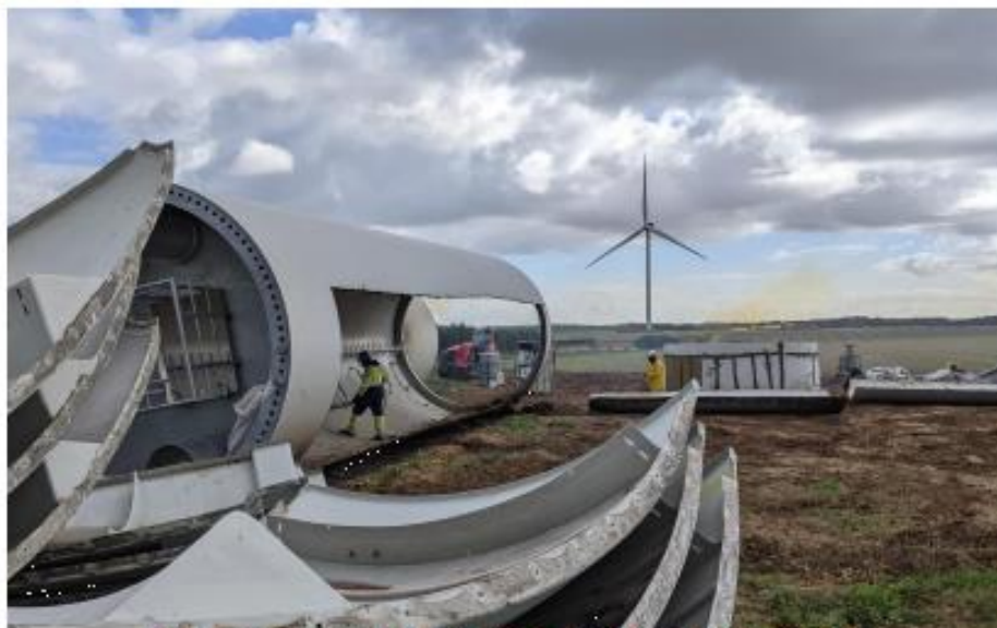
Figure 27 : Découpage du mât d'éolienne, parc éolien de Bougainville (80), Boralex septembre 2022
